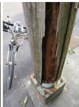
図 6.2 腐朽した柱
