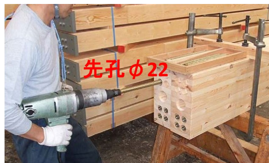
図 4.11 LSB 打ち込み状況
