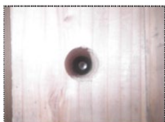
【切断後のスタッドとCLT孔位置】
