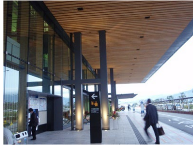
図 6.11 軒に樹脂処理した木材の使用例
