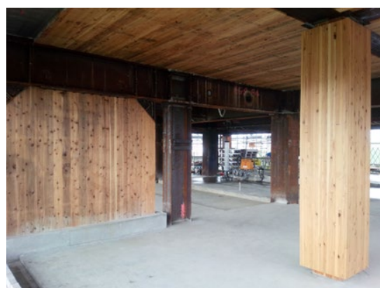
写真 8.4 泉高森プロジェクト工事中の風景
