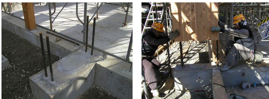
図 4.14 GIRによる柱脚接合部の例
