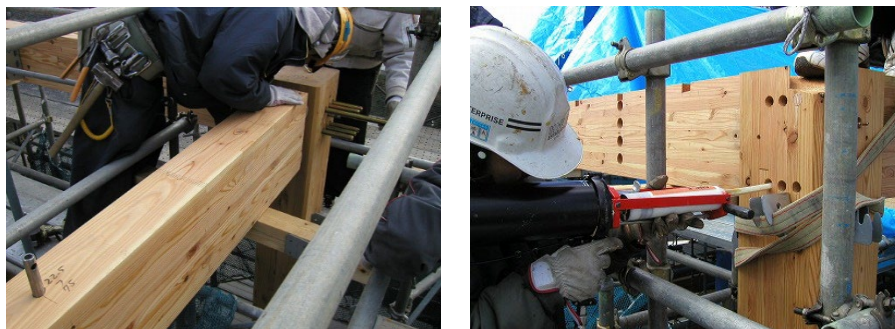
図 4.13 GIRによる柱-梁接合部の例
