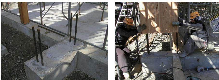
図 4.14 GIRによる柱脚接合部の例
