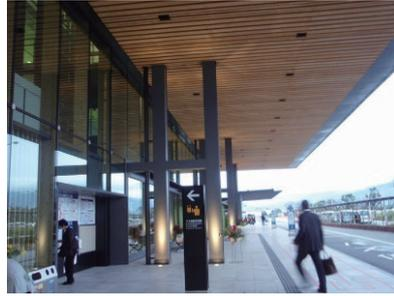
図 6.11 軒に樹脂処理した木材の使用例
