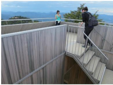
図 6.10 熱処理した木材の使用例
