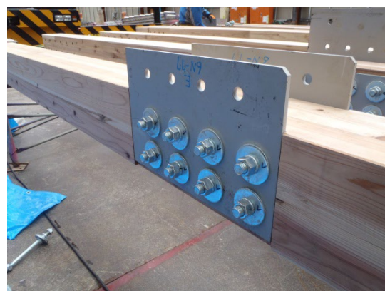
図 23.10 ボルト接合拡大
