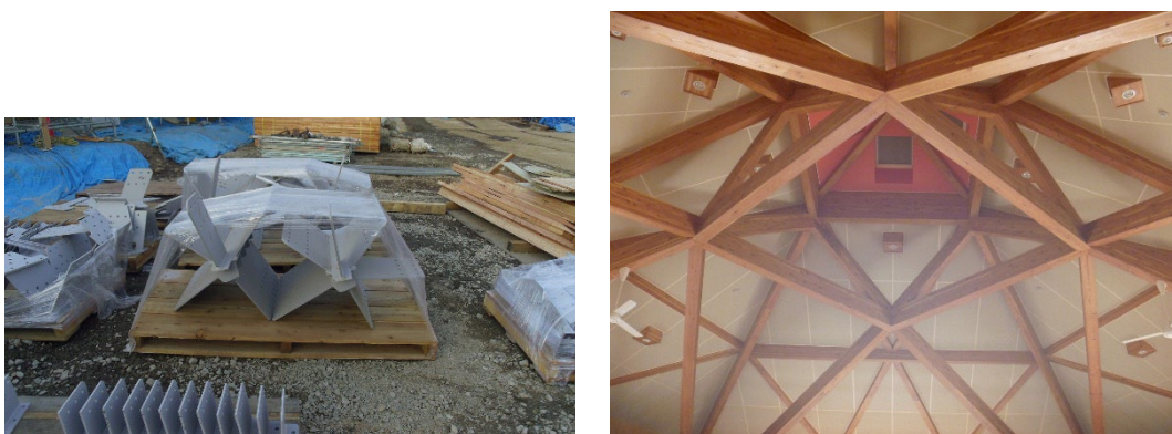
図 4.17 登梁受け金物 (左：登梁受け金物、右：使用部位)
