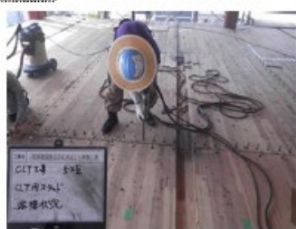
【スタッド溶接】
