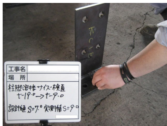
図 18.9 溶接サイズ検査
