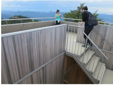
図 6.10 熱処理した木材の使用例
