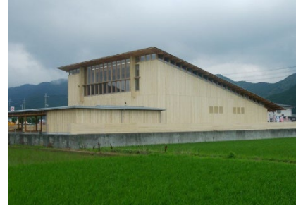
図 6.12 外壁にアセチル化処理した木材の使用例
