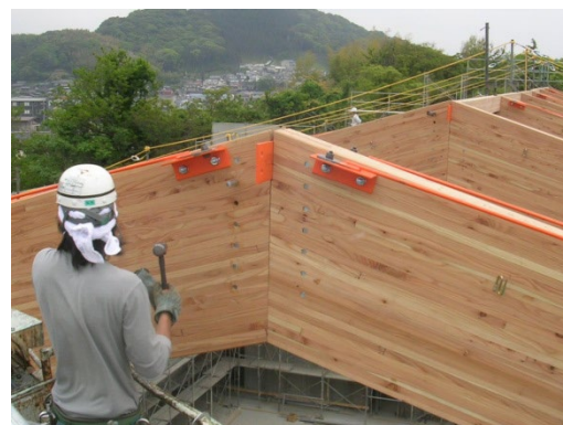
図 23.14 ドリフトピン接合拡大
