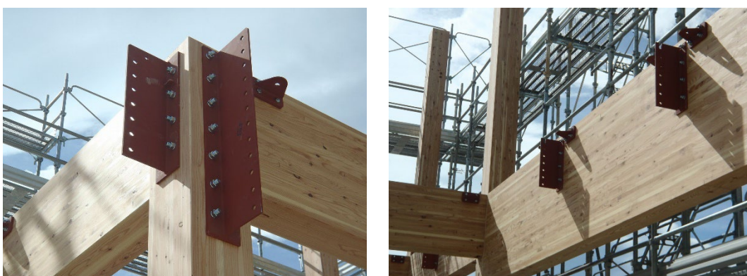
図 4.16 梁受け金物 (左：大梁受け、右：小梁受け)
