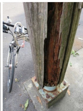
図 6.2 腐朽した柱
