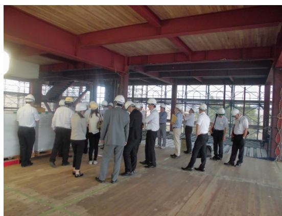
写真 8.2 松尾建設本店ビルの工事中風景
