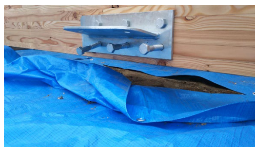
図 23.12 ラグスクリュー接合拡大
