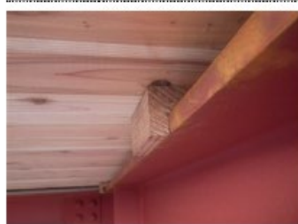
【CLTと梁のクリアランス確保】
