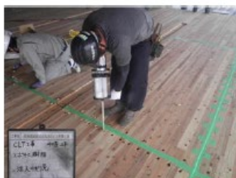
【エポキシ樹脂注入】
