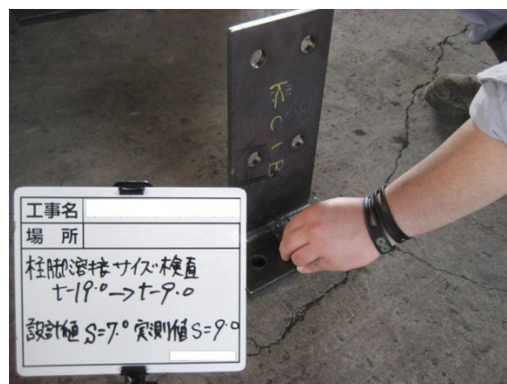
図 18.9 溶接サイズ検査
