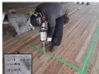
【エポキシ樹脂注入】
