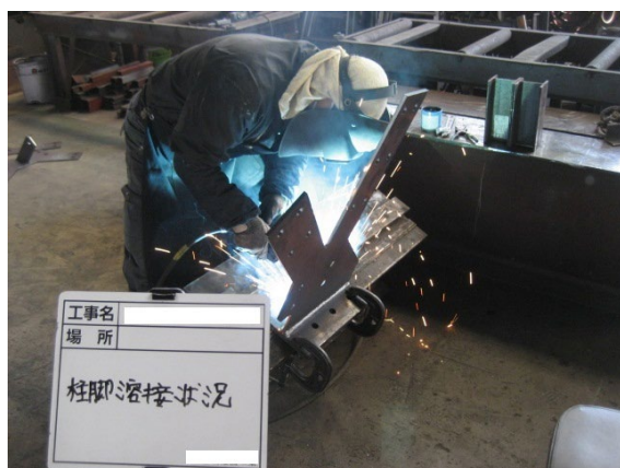
図 18.8 柱脚金物の溶接
