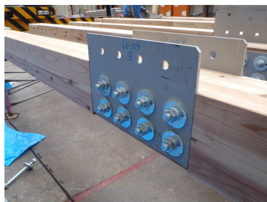
図 23.10 ボルト接合拡大
