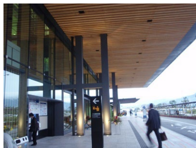
図 6.11 軒に樹脂処理した木材の使用例
