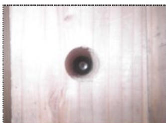
【切断後のスタッドとCLT孔位置】
