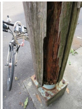
図 6.2 腐朽した柱
