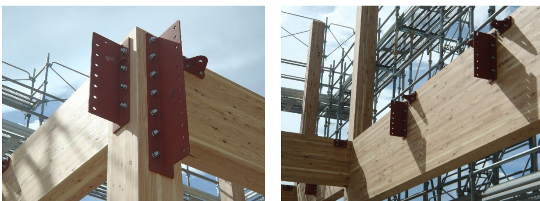
図 4.16 梁受け金物 (左：大梁受け、右：小梁受け)
