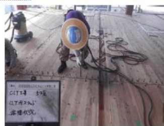
【スタッド溶接】
