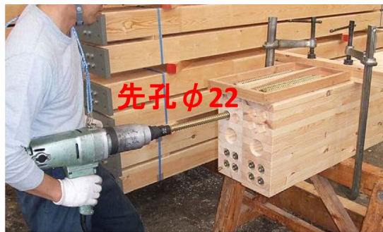
図 4.11 LSB 打ち込み状況
