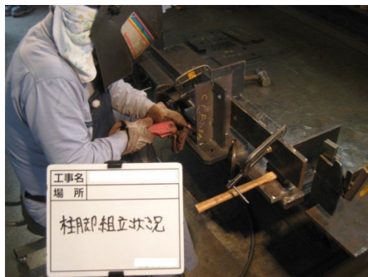
図 18.6 柱脚金物の組立て
