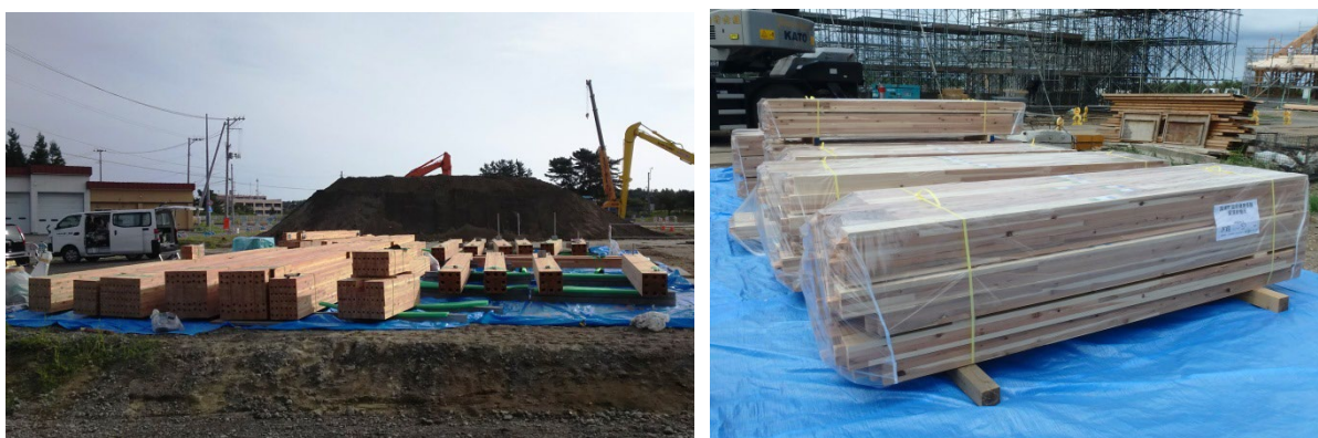
図 22.6 木質構造部材の荷置き状態
