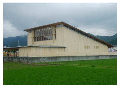
図 6.12 外壁にアセチル化処理した木材の使用例
