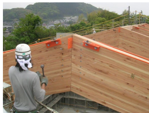
図 23.14 ドリフトピン接合拡大
