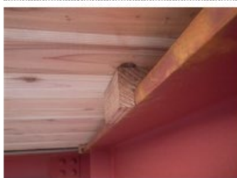
【CLTと梁のクリアランス確保】
