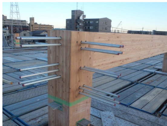
図 23.16 GIR 接合断面
