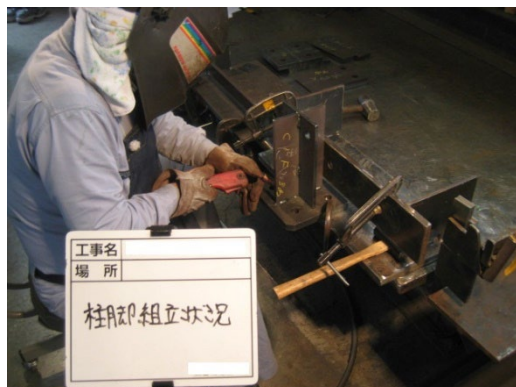
図 18.6 柱脚金物の組立て
